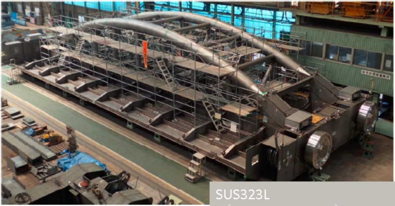
Vista de la compuerta en su proceso de construcción
